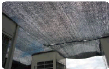
北関西試験センター屋上の遮光ネット
