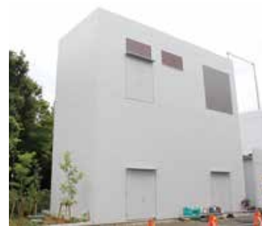
特殊空調校正室外観
