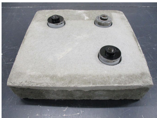
コア抜き・治具取付後
