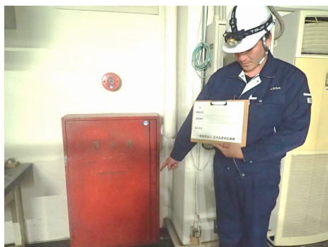
消火栓の確認状況
