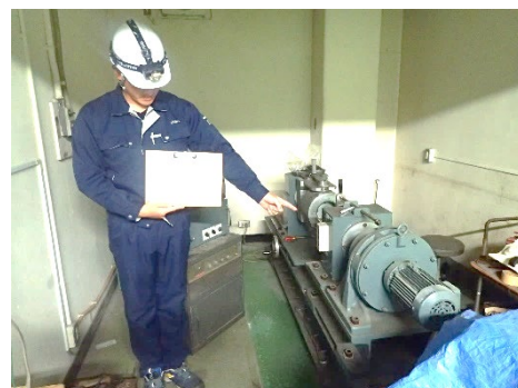
機械設備の確認状況
