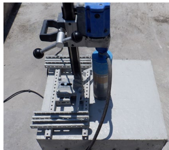
コア抜き状況
