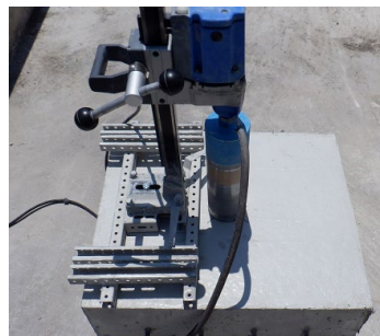
コア抜き状況
