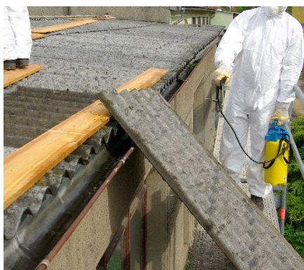
※アスベスト含有スレート波板の解体中
