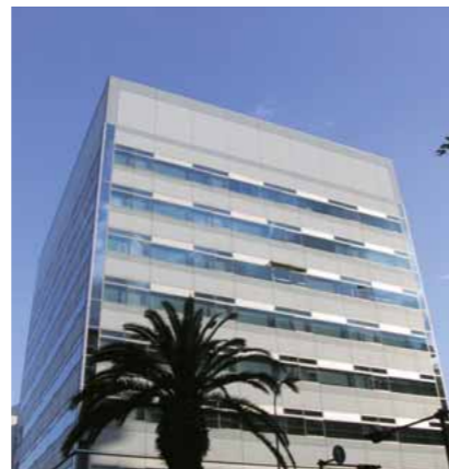
サン・データセンターの入居しているビル
