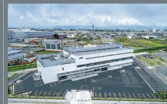
中部試験センター新試験所
