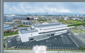
中部試験センター新設事務所
