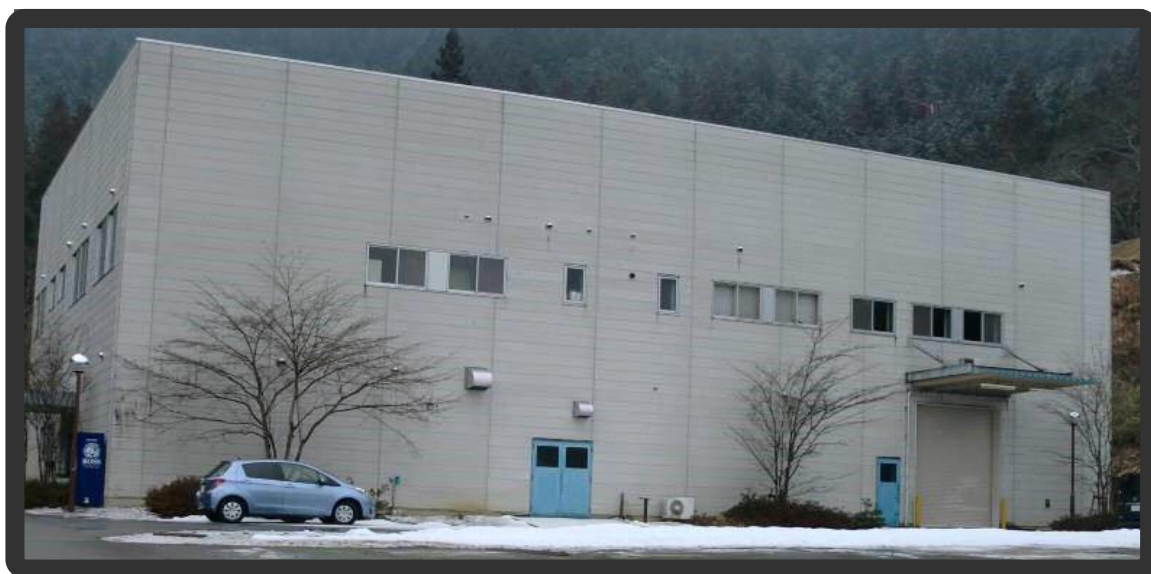
- 都留EMC試験所 電波暗室棟 -
