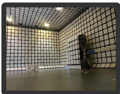
- 10m法電波暗室 -
