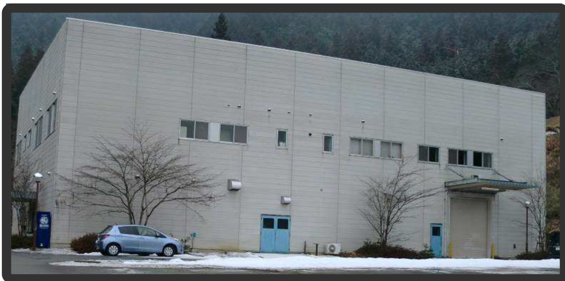
- 都留EMC試験所 電波暗室棟 -
