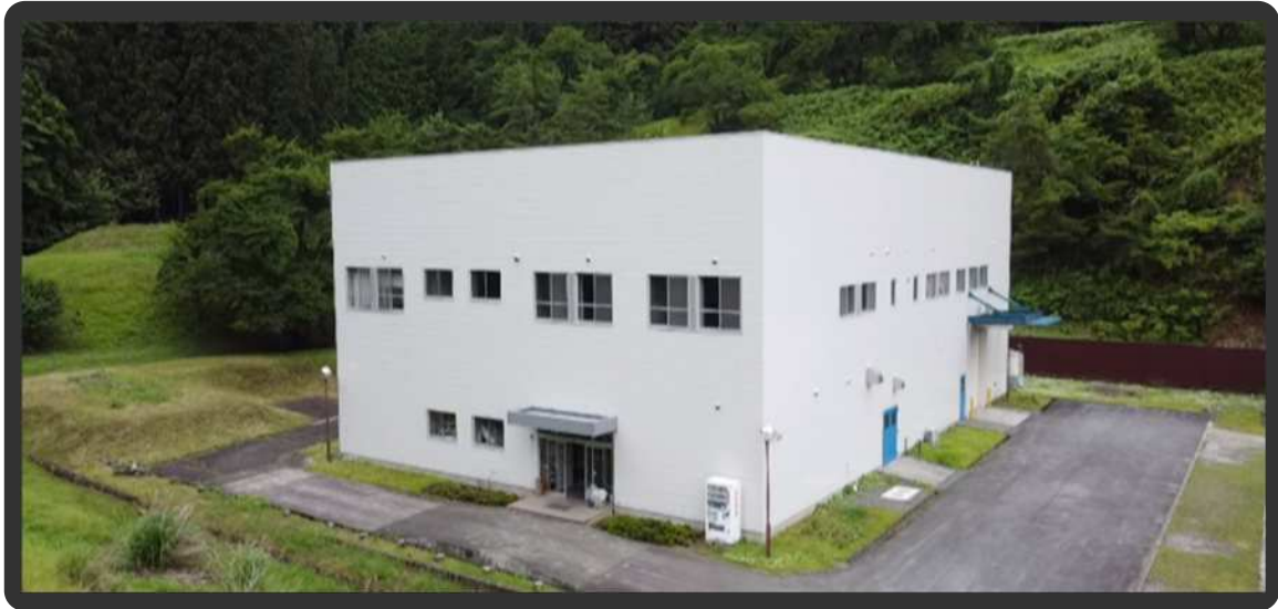
- 都留EMC試験所 電波暗室棟 -
